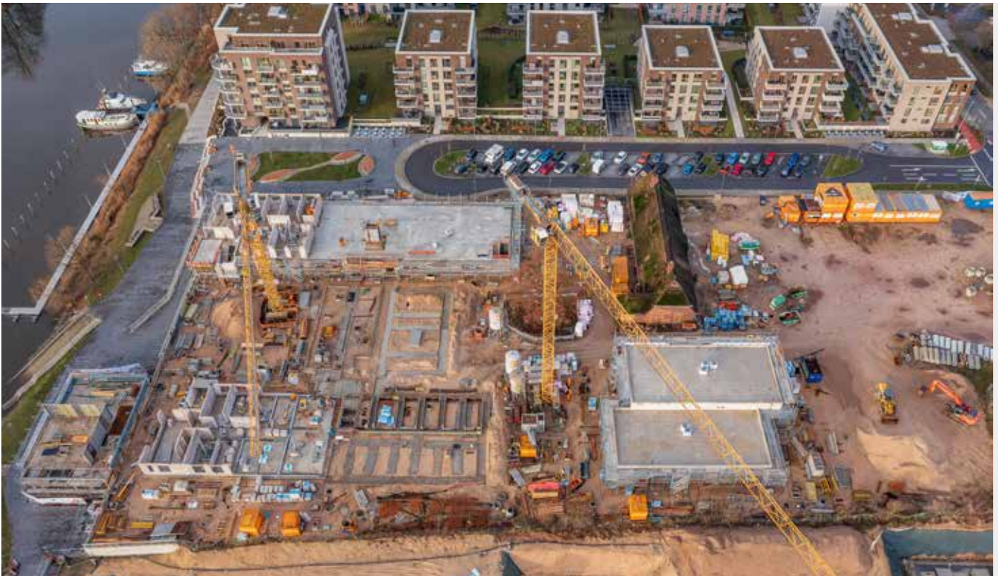
Blick auf die Baustelle: Direkt an der Elbe entstehen ein modernes Pflegezentrum und eine Kindertagesstätte.
